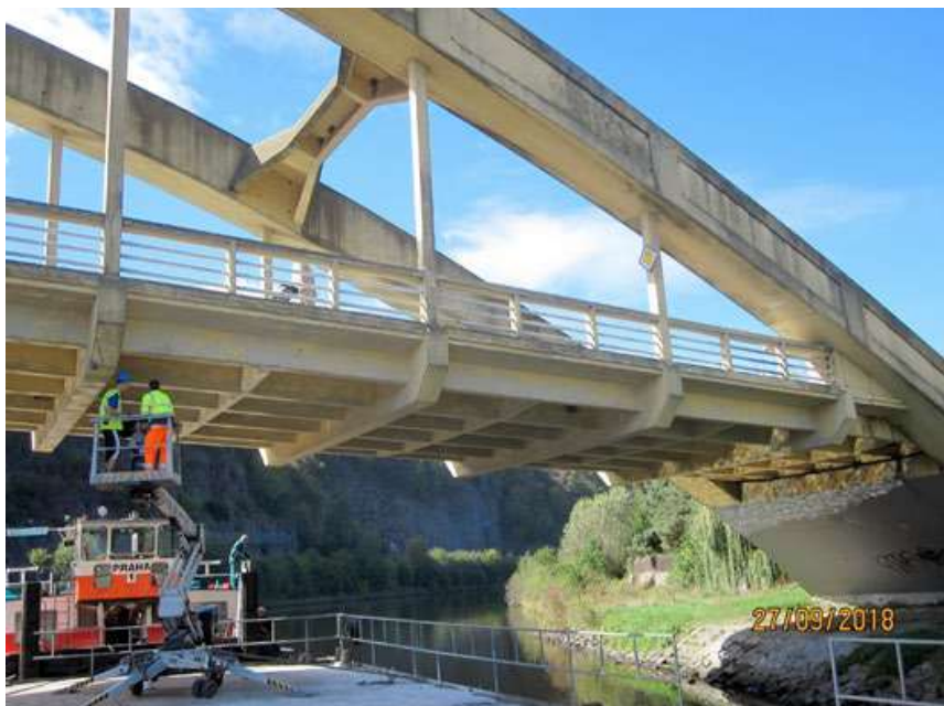
Obr. 4 Prohlížení a diagnostika mostu prováděná z plošiny na pontonu.
