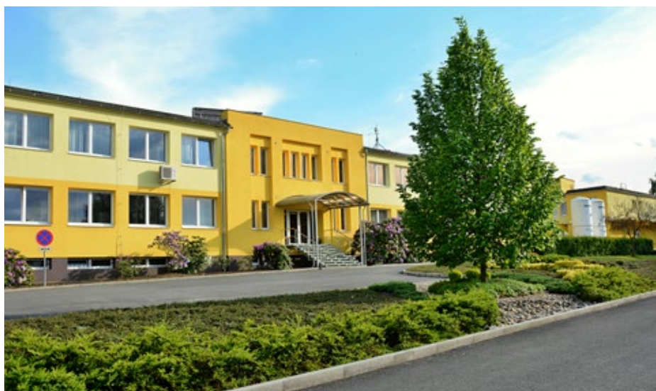
Hlavní budova v areálu ČMSCH.
