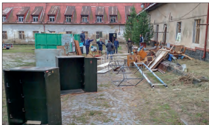
V sobotu 20. října byl vyklizen nově získaný společenský sál sousedící s tělocvičnou. Na pomoc přišli kromě zastupitelů i členové místních spolků. Více na str. 5.
